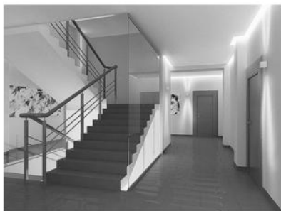
Эвакуационная лестница 2-го типа (открытая)
